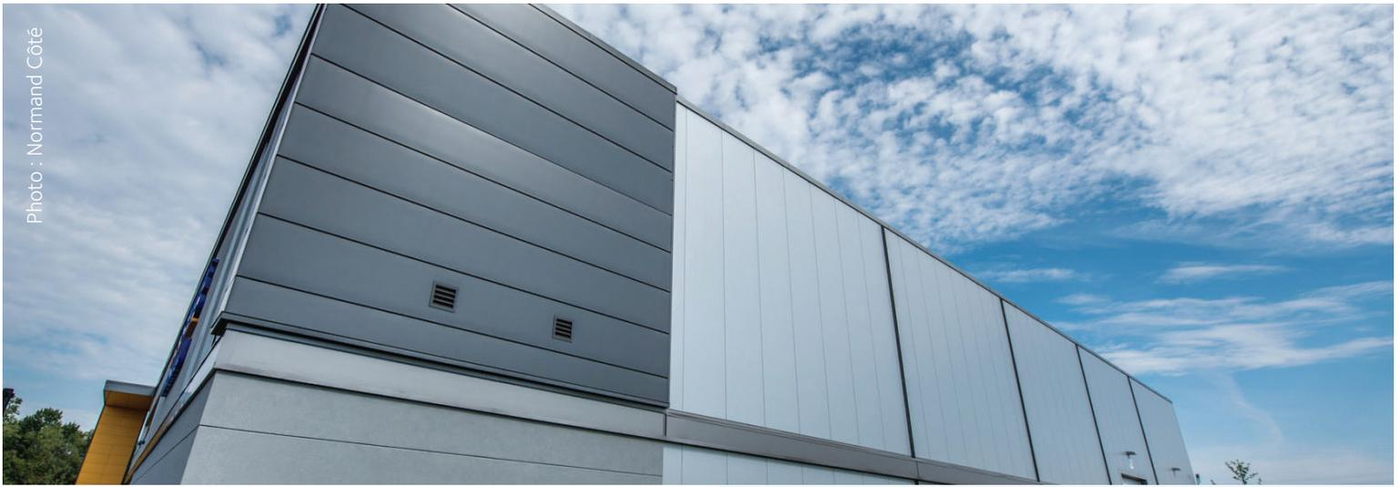
Les architectes ont choisi ces panneaux Norex hautes performances pour diverses raisons, leur rapidité et leur facilité d'installation. « En raison d'un calendrier de construction serré pendant l'hiver, l'installation de panneaux préfinis a facilité le séquençage et nous a permis de clôturer rapidement le bâtiment avec un seul métier », a déclaré M. Côté.
