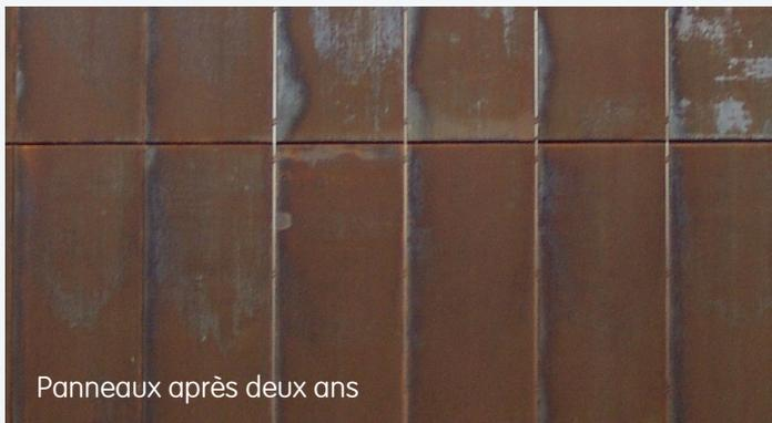
La surface exposée des aciers résistants aux intempéries change au fil du temps, passant d'un fini gris foncé à une patine orangée en quelques semaines, évoluant continuellement jusqu'à atteindre une couleur brun foncé finale.
