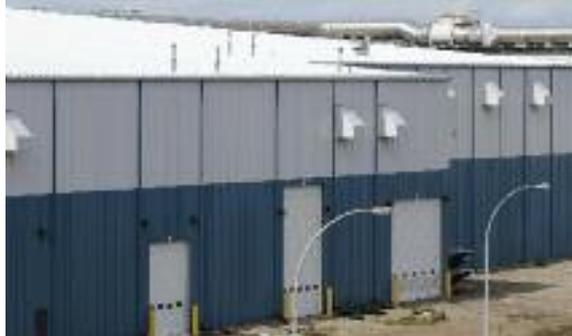
Le toit à joint debout de ce bâtiment est revêtu de 19 417 m<sup>2</sup> (209 000 pi<sup>2</sup>) de Galvalume AZM165 Plus non peint de 61 mm (0,0239 po) d'épaisseur et d'un revêtement en acrylique.
