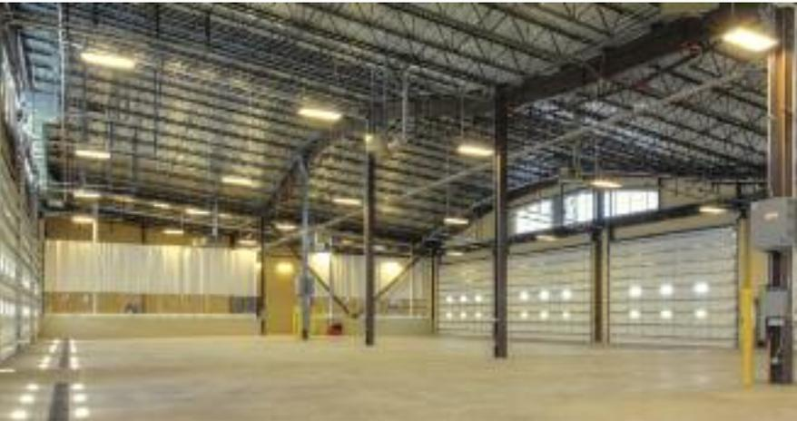
Le toit comporte un toit-terrasse en acier forgé pour le renvoi par-dessus des poutrelles d'acier en treillis de 660 mm (26 po) de profondeur soutenues par une structure en acier rigide.
