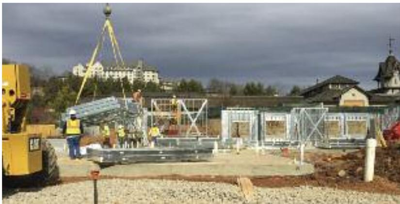
La construction de bâtiments de taille moyenne de 4 à 9 étages à l'aide de panneaux d'acier formé à froid est beaucoup plus abordable que les constructions plus lourdes. Aussi, les temps de construction sont plus faciles à prédire et peuvent être raccourcis de plusieurs mois.
