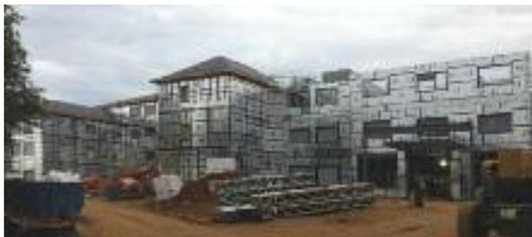
Les structures de bâtiments en acier formé à froid peuvent être installées beaucoup plus rapidement que celles faites avec les matériaux lourds et traditionnels comme le béton et la maçonnerie. La construction d'un bâtiment de taille moyenne peut être raccourcie de trois mois ou plus. L'acier formé à froid vous permet de servir des clients plus rapidement et ainsi réduire considérablement vos coûts.
