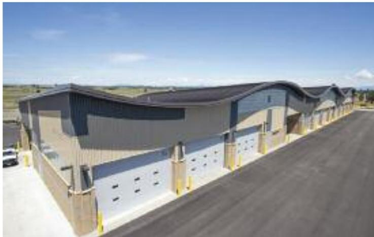
Pour obtenir un style qui plaît autant au client qu'aux architectes, l'équipe de M. Cortner a opté pour un « toit roulant » en acier, une idée inhabituelle. Le toit comporte un toit-terrasse en acier forgé pour le renvoi par-dessus des poutrelles d'acier en treillis de 660 mm (26 po) de profondeur soutenues par une structure en acier rigide.
