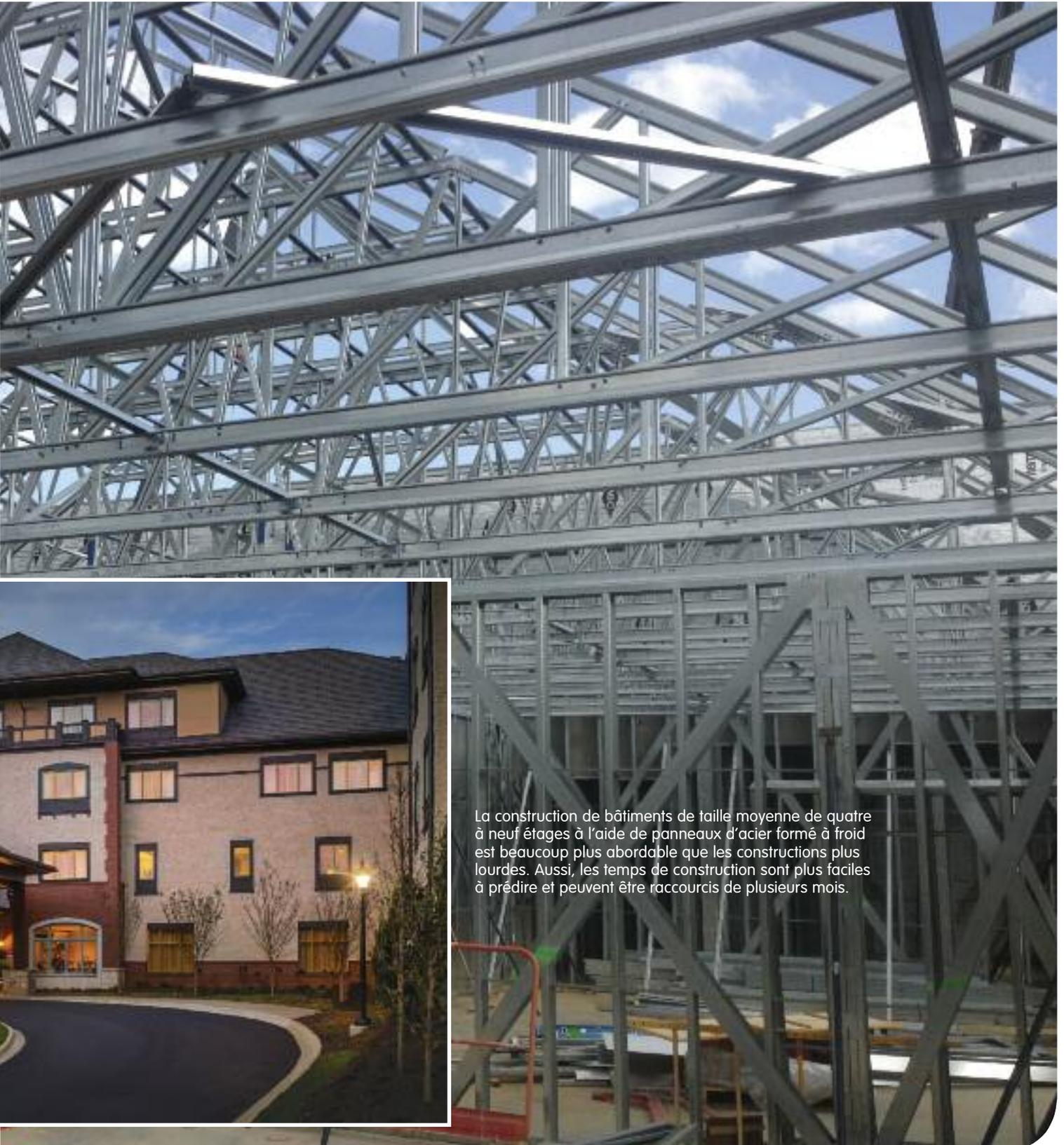
La construction de bâtiments de taille moyenne de quatre à neuf étages à l'aide de panneaux d'acier formé à froid est beaucoup plus abordable que les constructions plus lourdes. Aussi, les temps de construction sont plus faciles à prédire et peuvent être raccourcis de plusieurs mois.
