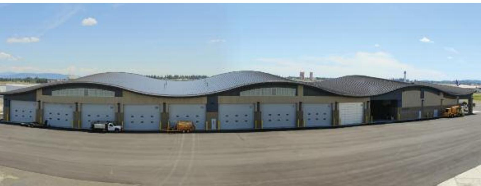
Le toit comporte plus de 5 205 m<sup>2</sup> (56 000 pi<sup>2</sup>) de panneaux à joint debout Magna-Loc, 0,61 mm (0,0239 po) et 404 mm (16 po), ornés de stries bronze foncé. Des panneaux muraux IC72 finis au PVDF couvrent les murs et sont revêtus d'une couche de Galvalume AZ50 (AZM150 au Canada) de 0,61 mm (0,0239 po) d'épaisseur, de couleur ardoise et kaki.
