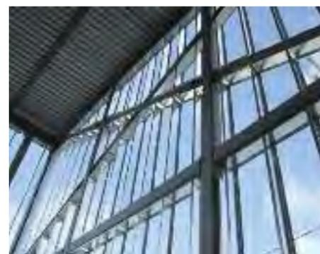
Élévation nord montrant l'utilisation intensive du revêtement mural Galvalume AZM150 de 22,2 mm (7/8 po).
