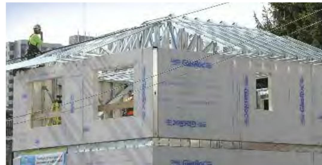
Finition de l'extérieur avec revêtement mural vertical Stratus et panneaux AR38 pour la toiture.
