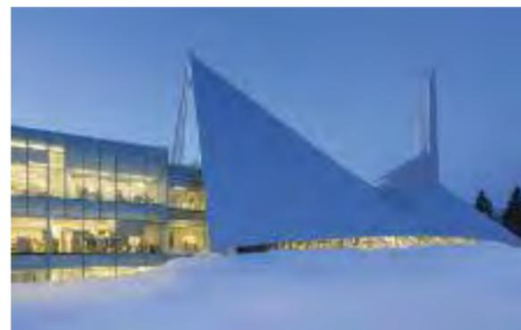
Pour accentuer la fluidité du volume, le soffite au-dessus de la fenêtre sous la toiture en forme de tente a été remplacé par des panneaux de verre qui permettent à chaque poutre de se glisser visuellement dans sa base extérieure d'acier, une véritable révélation en termes de continuité visuelle.
