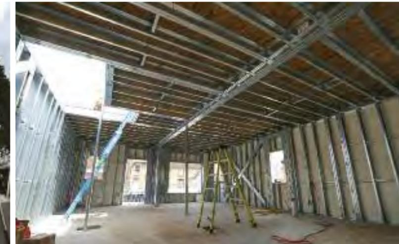
Vue intérieure montrant des fermes de toit préfabriquées, des panneaux muraux préassemblés et des poteaux muraux intérieurs. Le système de plancher comprend un système de panneaux en AUF avec un revêtement en béton armé.
