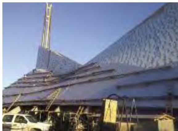
Les 2 800 m<sup>2</sup> (30 139 pi<sup>2</sup>) de bardeaux, en raison de leur petite taille, épousent les courbes complexes du toit, mais ils couvrent aussi efficacement le clocher de 27,43 m (90 pi) de hauteur à l'autre extrémité du toit. Le faîte culmine à environ 26,82 m (88 pi).
