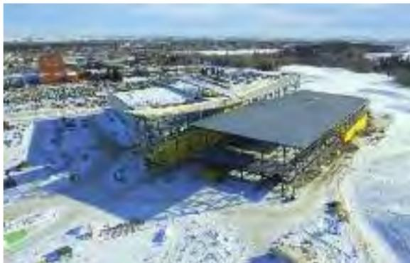
Aréna inachevé montrant une utilisation intensive de sections porteuses en acier usiné à froid sur les murs extérieurs.
