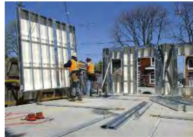
Les panneaux muraux en AUF sont préfabriqués avec une précision exceptionnelle dans un environnement contrôlé, comparativement aux conditions imprévisibles lorsque tout l'assemblage se fait sur le site. Cela garantit non seulement un niveau de qualité supérieur, mais évite également les retards imprévus dus aux conditions météorologiques et à d'autres facteurs.
