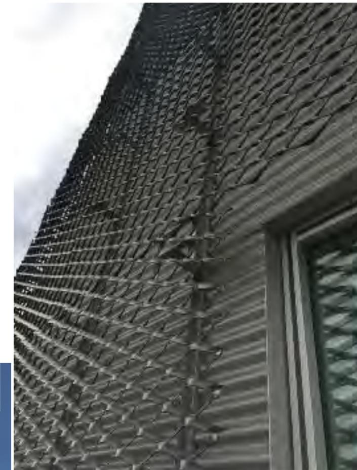
Du treillis de métal déployé a été installé sur le Galvalume.
