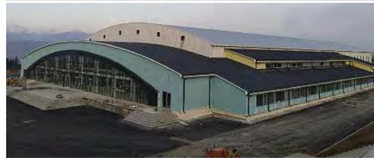
Le grenier ventilé formé par le système de poutres de toiture contribue à réduire les coûts énergétiques et à éliminer le risque que l'isolant se sature d'humidité en raison de la condensation ou de fuites se trouvant dans le revêtement de toiture léger d'autres systèmes de construction.
