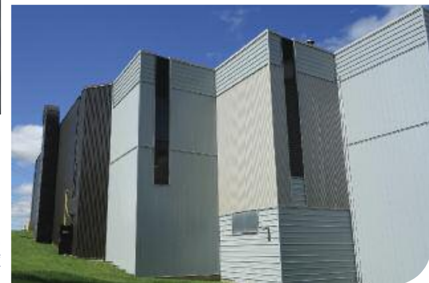
Section murale typique : la brique a été retirée, puis la membrane autocollante pare-air et pare-vapeur Blueskin de même que l'isolant rigide ont été installés. Une fois les barres en Z en place, les parements horizontaux et verticaux ont été installés, en fonction de l'emplacement.
