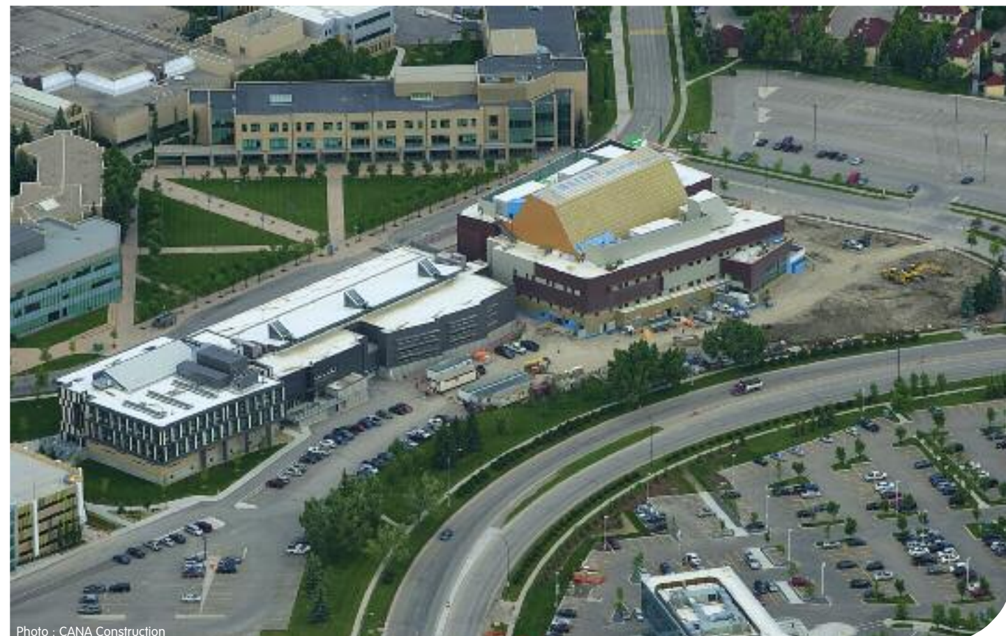
Photo : CANA Construction
