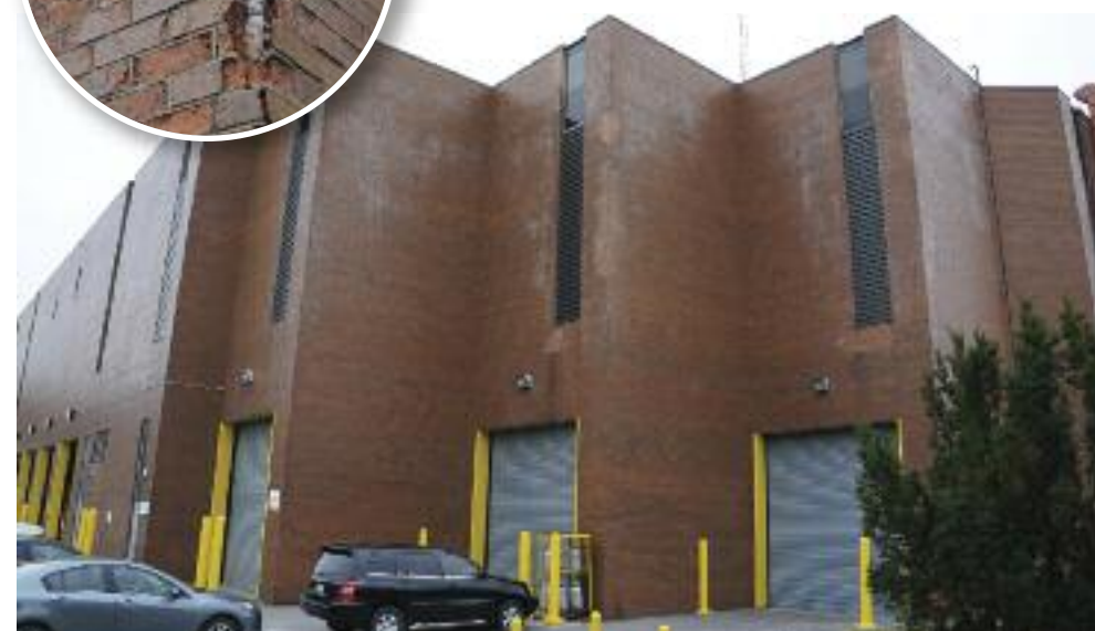
L'édifice de brique original ainsi que le contre-mur ont été construits au début des années 1970 sans cavité d'écran pare-pluie, ce qui était courant à ce moment. Par conséquent, l'humidité qui s'infiltrait par la maçonnerie était incapable de s'échapper. La brique s'est alors fendue et la surface externe s'est effritée et est tombée.
