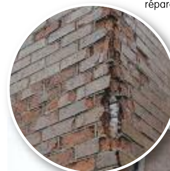
L'édifice de brique original ainsi que le contre-mur ont été construits au début des années 1970 sans cavité d'écran pare-pluie, ce qui était courant à ce moment. Par conséquent, l'humidité qui s'infiltrait par la maçonnerie était incapable de s'échapper. La brique s'est alors fendue et la surface externe s'est effritée et est tombée.
