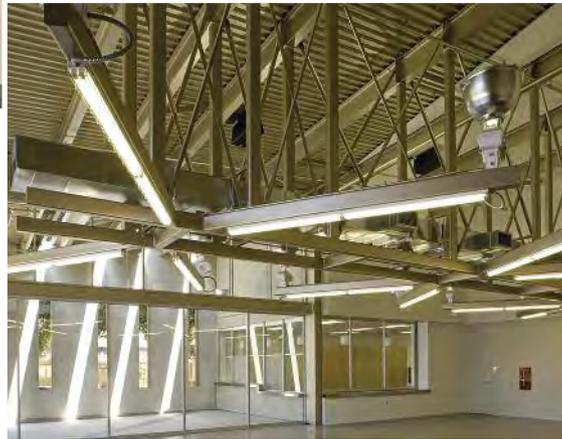
Photographie montrant un profilé en acier creux (HSS) utilisé pour la charpente légère de soutien dans le hall d'entrée.
