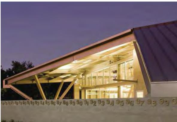
Une toiture à joint debout simple, recouvrant un assemblage d'éléments fonctionnels, procure une lecture simple de ces fonctions complexes tout en diminuant la masse du cintre d'une hauteur de 19,8 mètres (65 pieds).
