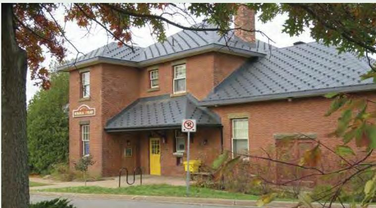
Élévations au sud et au nord-ouest de la gare ferroviaire historique de Wolfville dont le toit a été remplacé, maintenant la bibliothèque de Wolfville, montrant le nouveau modèle de tuile en forme de losanges fabriquée à partir d'acier Galvalume AZM150 prépeint 0,45 mm (0,0179 po) d'ArcelorMittal Dofasco, utilisant le système de peinture Granite Deep Mat de couleur gris graphite QC60036, avec pare-neige.
