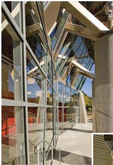
Des entretoises en acier surmontant des colonnes de béton massif s'agencent aux chênes devant le hall d'entrée et soutiennent la structure exposée du toit au-dessus de la cour d'entrée en contrebas abritée par une structure ramifiée conçue pour inspirer des performances extérieures spontanées.
