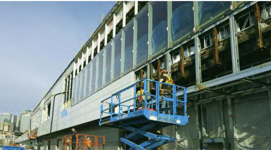
Norex est un panneau à âme de polyuréthane qui procure une valeur thermique inégalée. Il fournit des barrières de protection contre le feu et la pluie ainsi qu'une résistance au vent et aux déchirures grâce à son système d'ancrage exclusif lorsqu'il est installé. La conception de ce produit est sans cavité et possède une barrière thermique réduisant le risque de pénétration de la condensation et donc, de l'humidité.
