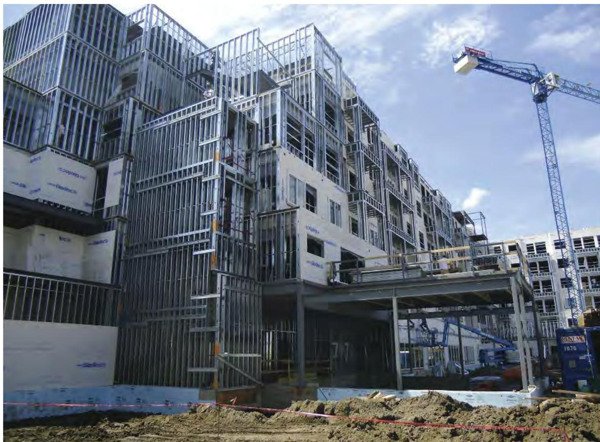
Un bâtiment en acier caractérisé par l'absence de murs porteurs est évidemment plus polyvalent et flexible que n'importe quel autre type de structure.
