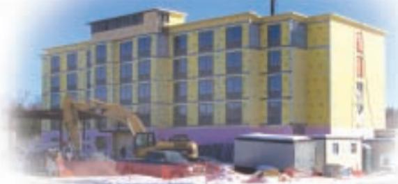
les dalles avant la phase suivante de l'érection des panneaux de mur fournis par FNA. Ceci avait aussi pour résultat que les autres gens de métier pouvaient entamer leurs travaux selon une base par étage immédiatement après l'érection des panneaux de FNA. »
