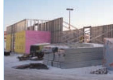
Le système de charpente métallique légère (CML) s'est avéré être la solution idéale pour les deux projets hôteliers dont l'érection des structures s'est effectuée durant l'hiver.
