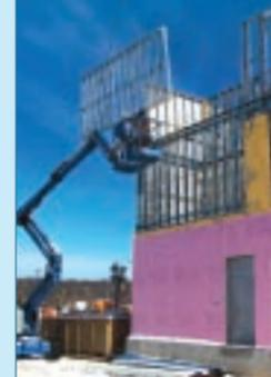
L'installation d'un système de charpente métallique légère (CML) est aisée, et cela entraîne des conséquences bénéfiques sur l'échéancier global de production. C'est l'une des principales raisons qui ont motivé le choix de ces matériaux pour la réalisation de ces projets.
