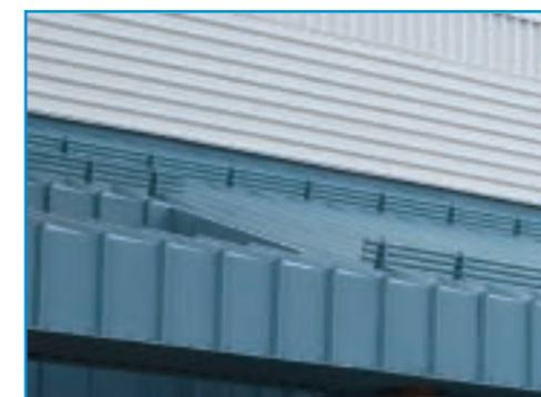
**Avec la finition du soffite du toit incliné Aqua Jewel et les éléments de garniture assortis, les coins taillés à onglet du parement mural horizontal Arctic White, illustré ici et en page 10, donnent à la station de traitement d'eau une agréable apparence élégante et épurée.**
