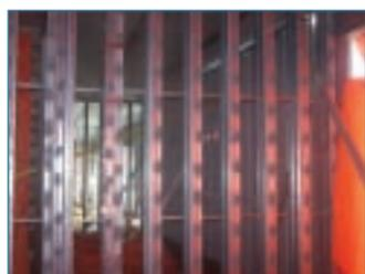
Vue d'un mur porteur type de rez-de-chaussée montrant une configuration à triple montants 1,72 mm à 406 mm centre à centre (triple 4" 0,068" à 16" centre à centre) dans chacune des composantes du mur à double paroi.
