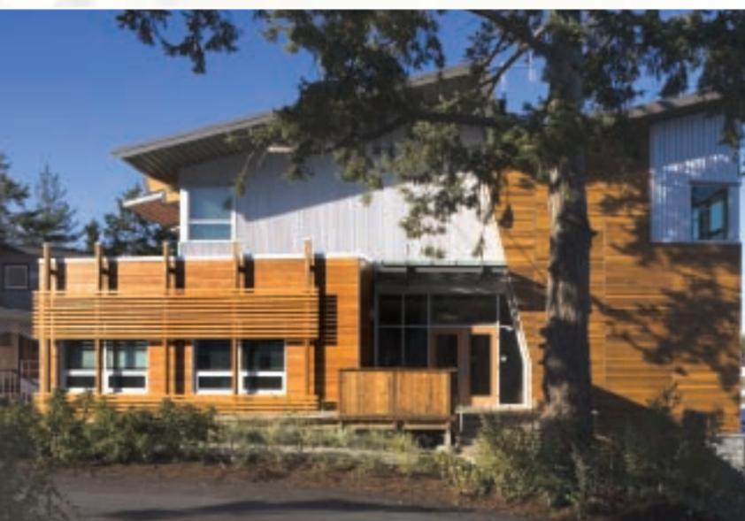
Une des caractéristiques de l'édifice est un toit en dents de scie symbolisant les rochers typiques d'une bonne partie du littoral des îles Gulf. Chaque façade a été conçue pour s'adapter à son orientation. Les matériaux de finition extérieurs sont le cèdre rouge de l'Ouest et un parement en acier Galvalume prépeint.
