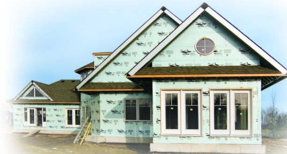
Les murs extérieurs sont constitués de poutres en acier de construction de 92 mm (3 5/8 po) avec revêtement mural extérieur hautement isolé. Plus de 98,4 % du mur creux est rempli de mousse de polycynène isolante, un matériau sans danger pour l'environnement.
