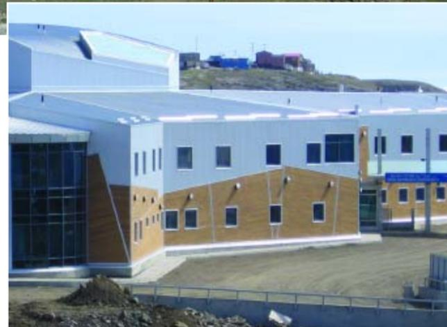
L'acier non peint Galvalume Plus<sup>MC</sup> AZM180 utilisé pour le toit, tel que fourni par Agway Metals, offre un excellent niveau de réflectance solaire. Le temps l'a prouvé et la recherche a confirmé que les toits en acier Galvalume Plus durent plus longtemps sans nécessiter d'entretien important, tout en offrant une valeur exceptionnelle.
