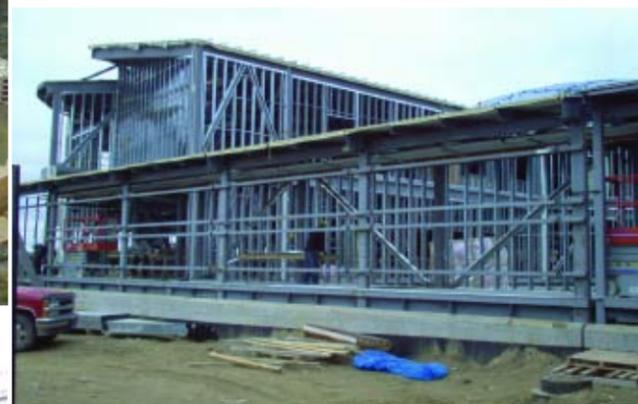
**Combinés au toit en acier Galvalume Plus, les matériaux sont évocateurs, économiques et écologiques. L'acier est fabriqué en majeure partie à partir de produits de post-consommation recyclés et sa couleur pâle permet d'éviter la création d'îlots thermiques.**
