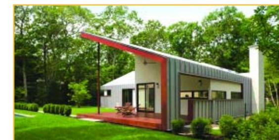
L'acier Galvalume prépeint de 0,61 mm (0,0239 po) avec finition en polymère fluoré Kynar 500 argent a été utilisé comme matériau pour la couverture et les murs.
