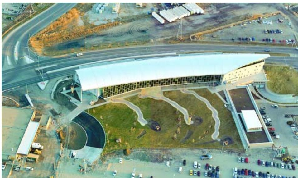
Vue aérienne du Calgary Water Centre, avec sa toiture à joint debout incurvée en acier Galvalume Plus AZM165, inspirée du dessin curvilinéaire de la route adjacente, qui a été modelée par la ligne du chemin de fer historique de la Grand Trunk Railway à cet endroit.
