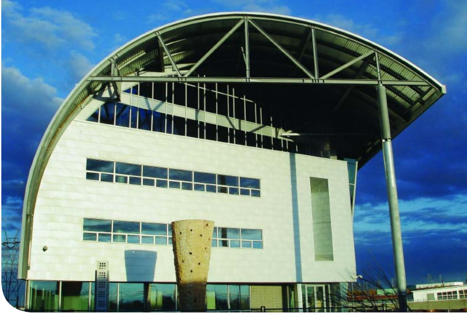
L'extrémité ouest du Water Centre présente des fermes Warren d'une hauteur maximale de 4,8 m (15,7 pi) s'élançant à partir de colonnes HSS 610 de 15 m (49 pi) de hauteur sur une ferme en porte-à-faux du bâtiment. On peut aussi voir le plâtrage en acier galvanisé respectant la norme ASTM 653, de Qualité 33, Z275 (G90) et les panneaux muraux de bardeaux en acier Galvalume Plus AZM165.
