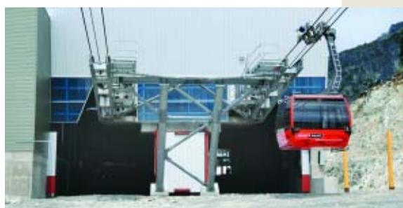
Vues de la station de téléphérique avec revêtement en Galvalume Plus et panneaux Rodeca translucides, qui permettent de voir le fonctionnement des éléments intérieurs.
