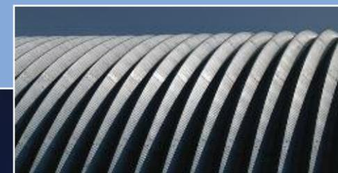
Les panneaux en forme d'arche, fabriqués à l'aide d'acier ondulé non peint Galvalume Plus AZM180 et d'une épaisseur de 1,9 mm (0,075 po) sont fournis par SteelMaster<sup>MD</sup> Buildings.
