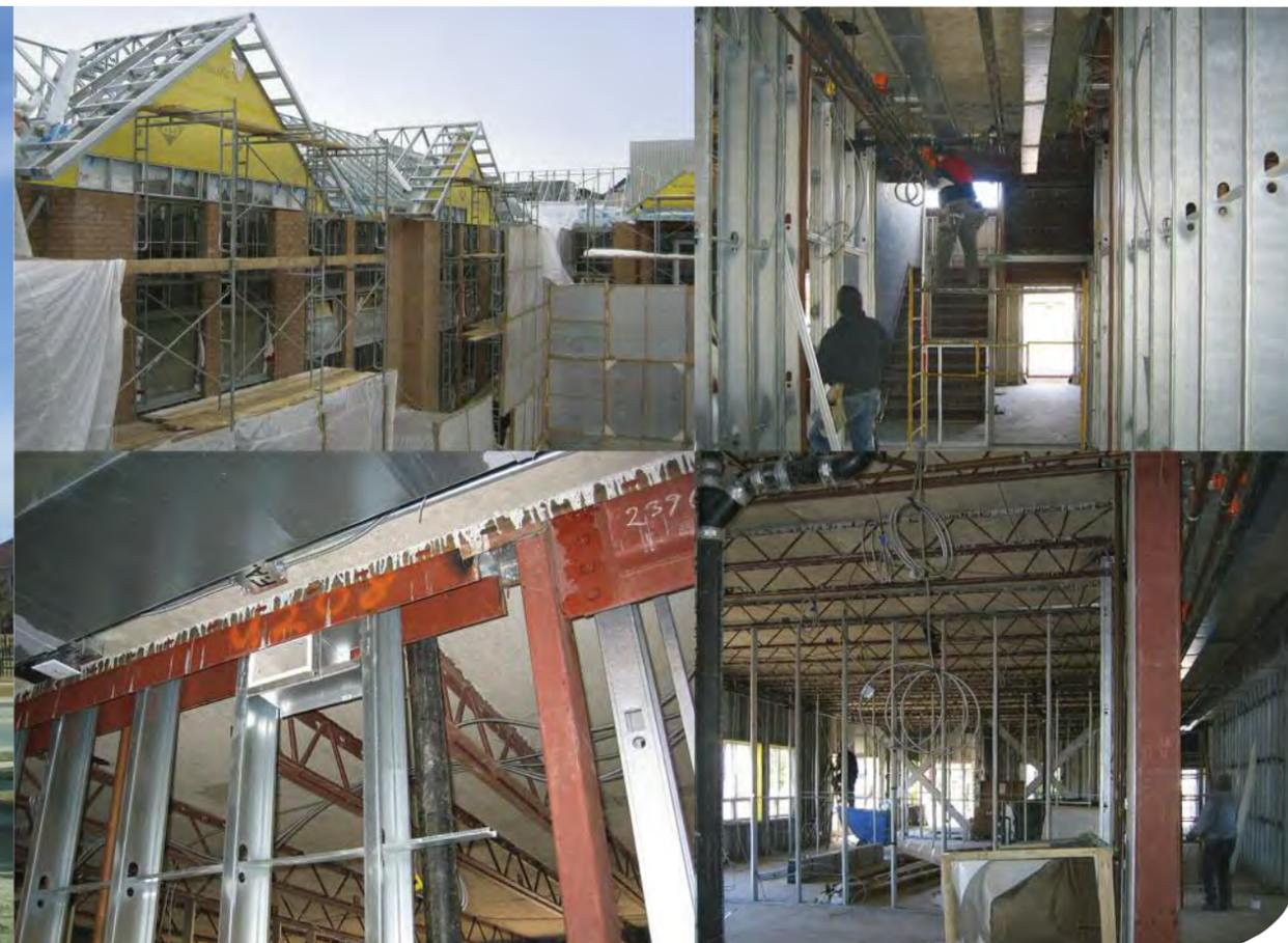
« Nous devons parfaitement intégrer et coordonner les différentes composantes du bâtiment, le tout d'une manière qui laisse place à une construction rapide et simple. Puisque la construction devait être faite de matériaux incombustibles, le propriétaire a opté pour l'acier. »
