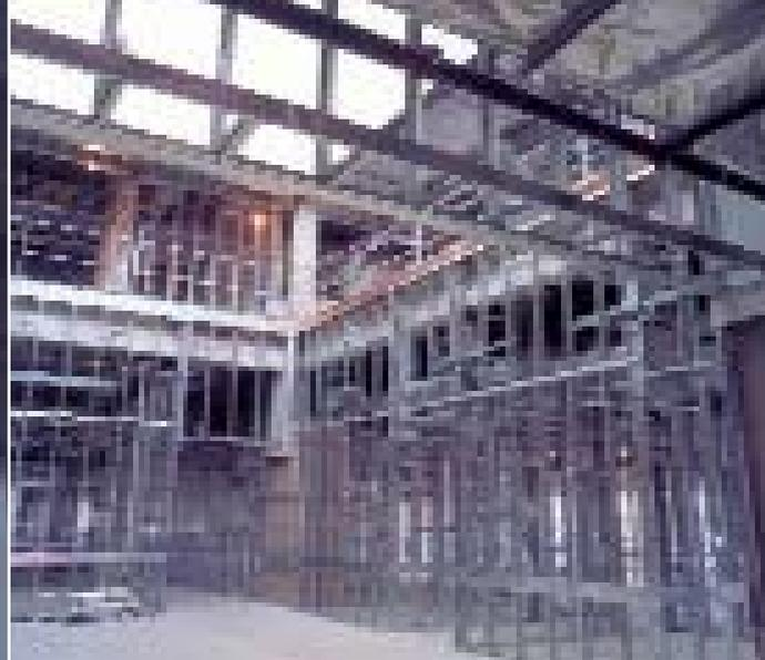
**Alors que la grille structurale est faite de 165 000 mètres (50 000 pieds linéaires) de charpente métallique légère en contrevent et 800 000 pieds linéaires de charpente métallique légère non porteuse en acier galvanisé et Galvalume de 0,92 mm à 0,46 mm (0,036 à 0,018 po), le périmètre entier du nouveau bâtiment emploie des poteaux d'acier galvanisé et Galvalume résistant au roulement de vent de 1,9 à 1,22 mm (0,75 à 0,48 po).**
