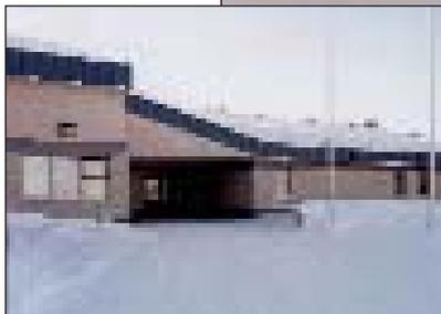
**La structure à un étage, dont les salles de cours sont construites autour d'un gymnase central, est formée d'un toit à joint debout de 6 600 m<sup>2</sup> (72 000 pi<sup>2</sup>) en Galvalume<sup>mc</sup> prépeint de couleur Bleu héron QC8330.**
