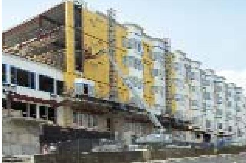
**CI-DESSUS : Façade nord. Les murs extérieurs sont en briques et en pierres pelliculaires avec fini de stucco, charpente métallique en contrevent et intérieur en cloisons sèches. L'isolant non combustible non projeté sur le revêtement extérieur sert de pare-vent et de coupe-vapeur.**
