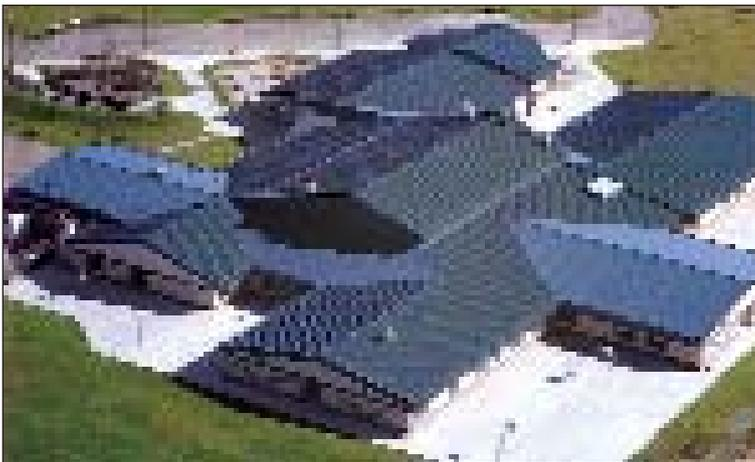
« Une toiture en acier est très efficace dans le Grand Nord. Vous pouvez atteindre des valeurs R très élevées avec un système en acier. Il peut faire face à la dilatation et à la contraction qui se produisent à des températures de  $-50\text{ }^{\circ}\text{C}$  à  $+30\text{ }^{\circ}\text{C}$  et, bien entendu, il nécessite peu d'entretien. »
