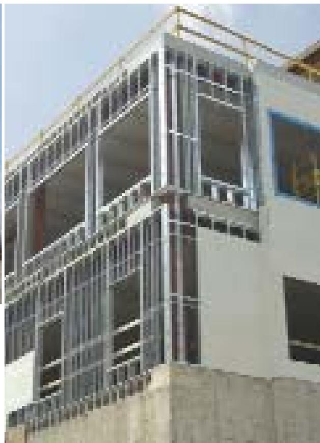
**CI-DESSUS ET CI-CONTRE : Les phases II et III comportent une charpente en fer et des sections en acier galvanisé structural usiné à froid de 1,097 mm (0,0432 po) en contrevent.**
