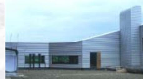
Le revêtement extérieur est fait d'acier Galvalume prépeint et d'un système de peintures en polyuréthane, couleur argent QC7500 (conçu pour s'harmoniser avec la couleur des panneaux de mur adjacents), et couvre le mur nord (niveau du toit) et les sections des murs d'extrémité est et ouest.
