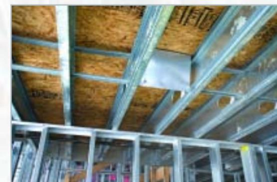
**Le système de solives de plancher i-SPAN diminue le travail en réduisant considérablement le nombre de pièces et d'attaches qui doivent être installées. Sa forme symétrique ainsi que la différence d'épaisseur entre le treillis et la membrure lui donnent une résistance, une rigidité et une efficacité accrues.**
