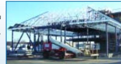
Le **toit inférieur est fait** de poutres en acier léger de 216 mm (inclinaison 8/12) – dont la distance entre le centre des poutres est de 812,8 mm (32 po) – supportées par une ossature portante d'acier. Les panneaux de toit en acier sont de 0,76 mm (0,0299 mm) galvanisés ZF075 avec un profil de 38,1 mm (1 1/2 po), plus un revêtement de contreplaqué de 12,7 mm (1/2 po).
