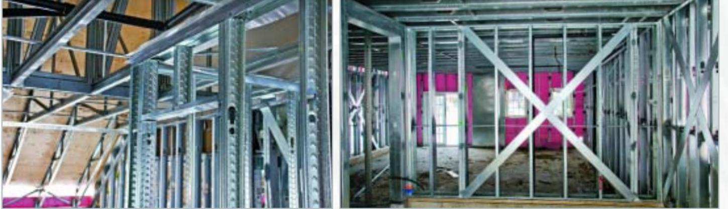
**Les maisons en rangée de trois étages disposent de systèmes de murs à charpente métallique légère pré-assemblés, du système de solives de plancher d'acier Genesis i-SPAN et du système de charpente de poutres métalliques légères mises au point et pré-assemblées.**
