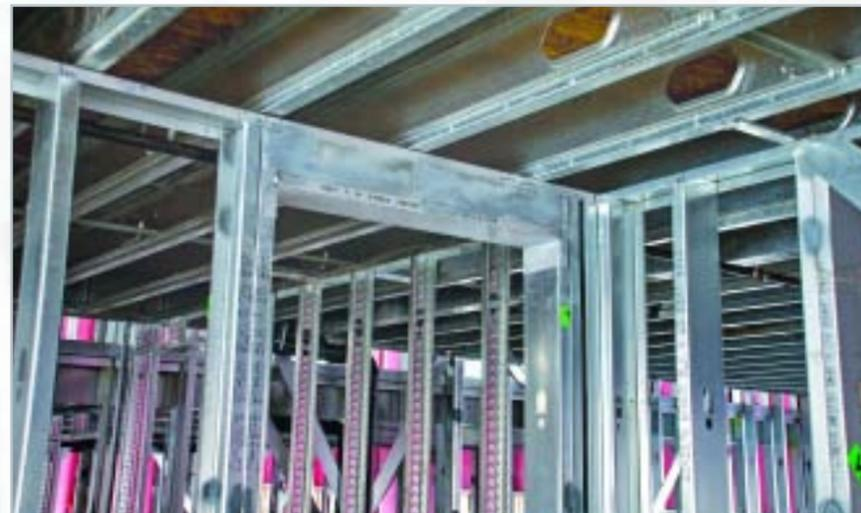
**Solive de plancher i-SPAN avec sous-plancher OSB et systèmes de murs pré-assemblés à charpente métallique légère au plafond.**
