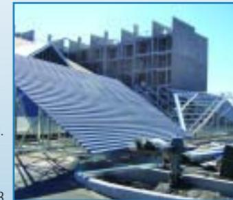
Le **toit supérieur est fait** de poutres en acier léger de 216 mm (inclinaison 8/12) – dont la distance entre le centre des poutres est de 812,8 mm (32 po) supportées par des poteaux d'acier léger de 1,09 mm (0,43 po) – dont la distance entre le centre des poutres est de 406,4 mm (16 po). ■
