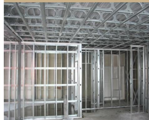
Les solives de plancher sont supportées par des systèmes de murs porteurs ayant des platelages en acier galvanneal ZF075 vissés aux solives. Les profilés de fourrure sont attachés aux solives pour éventuellement y attacher une cloison sèche. Les solives sont espacées de 609 mm à 1219 mm (24 po à 48 po) selon la travée et la charge. Les services mécaniques et électriques sont facilement installés.
