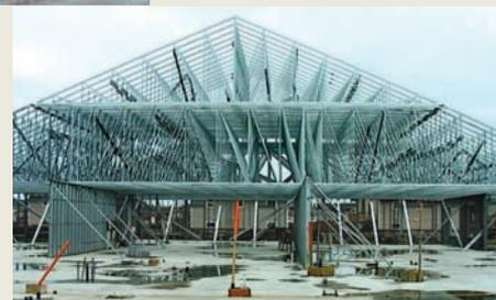
Le matériel et les éléments précoupés ont été assemblés pendant les mois d'hiver à Moose Factory. La construction sur le chantier a débuté au printemps. Les panneaux muraux ont été expédiés au chantier en juillet et le montage de la superstructure a eu lieu en juillet et en août.
