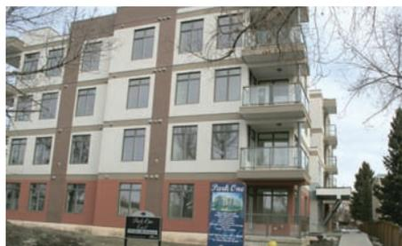
Avant du Park One East de quatre étages. L'enveloppe porteuse extérieure EIFS et les assemblages de panneaux intérieurs ont été assemblés en usine et ensuite envoyés au site. Ceci a permis d'avoir un meilleur contrôle de la qualité et d'éliminer les problèmes de conditions météorologiques et d'échafaudage lors de la construction.
