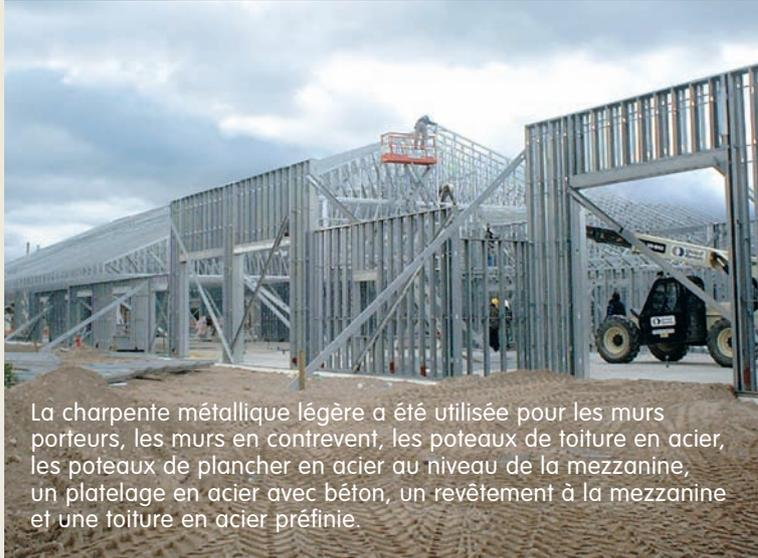
La charpente métallique légère a été utilisée pour les murs porteurs, les murs en contrevent, les poteaux de toiture en acier, les poteaux de plancher en acier au niveau de la mezzanine, un platelage en acier avec béton, un revêtement à la mezzanine et une toiture en acier préfinie.
