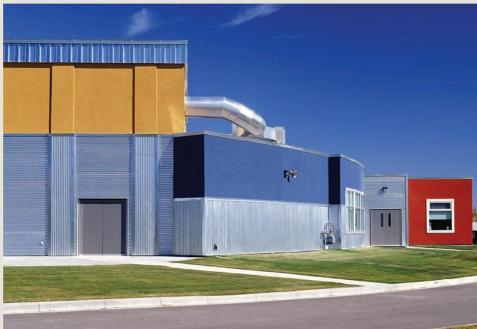
Le profilé traditionnel de 0,607 mm (0,0239 po) en acier galvanisé Z275 est utilisé tant pour la couverture à joint debout du gymnase que pour la bordure de toit de l'immeuble.
