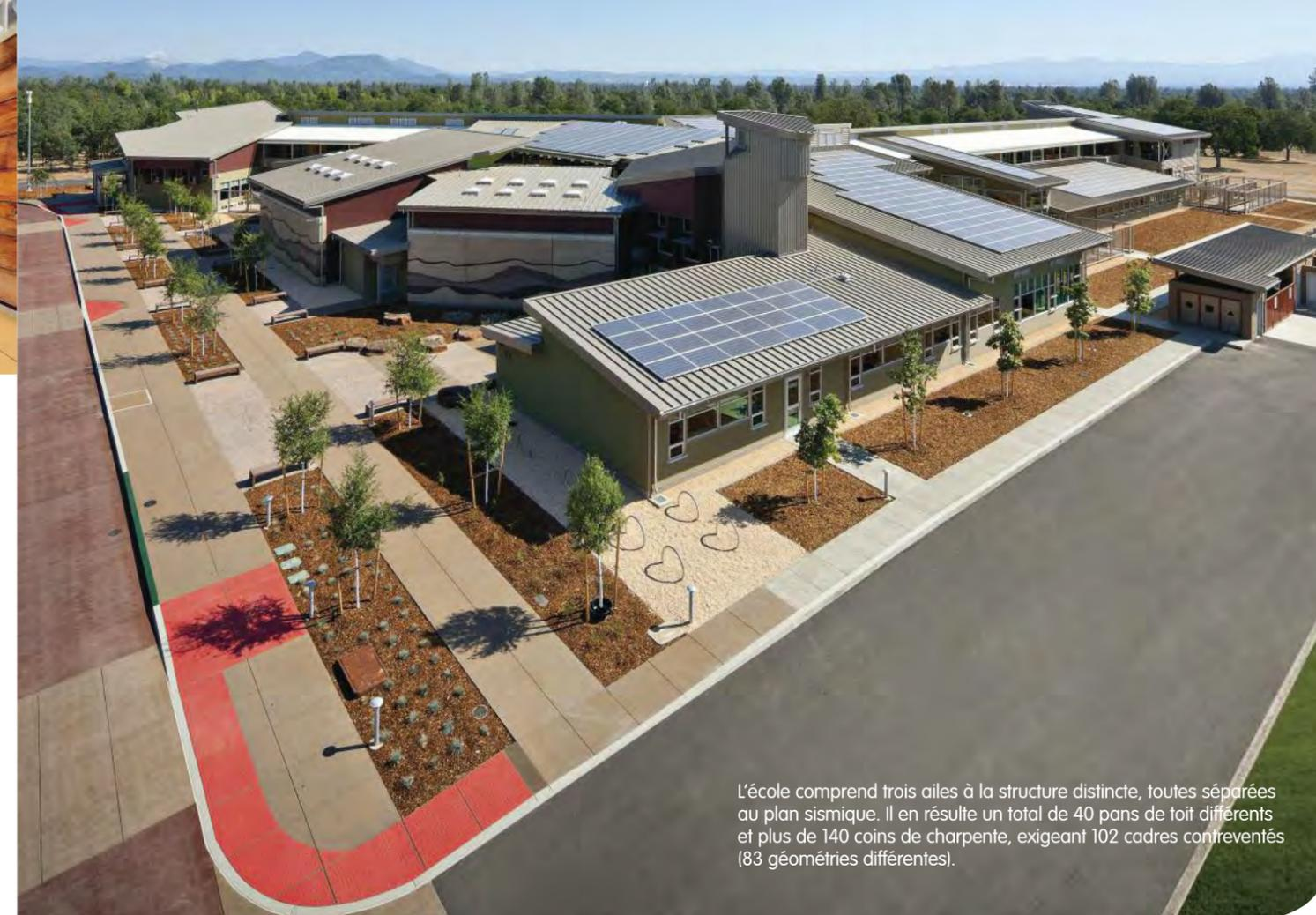
L'école comprend trois ailes à la structure distincte, toutes séparées au plan sismique. Il en résulte un total de 40 pans de toit différents et plus de 140 coins de charpente, exigeant 102 cadres contreventés (83 géométries différentes).
