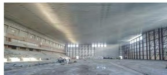
Le plafond d'aspect naturel offre un espace vif et clair qui minimise les luminaires et réduit les factures d'énergie. Ce plafond, sans ferme exposée, procure un espace intérieur lumineux doté d'une forte réflectivité. Dans ce cas, les panneaux du plafond sont des panneaux galvanisés Z275(G90) de 1,93 mm (0,0758 po). Le fer rouge structurel dans la photo est exposé au vent.
