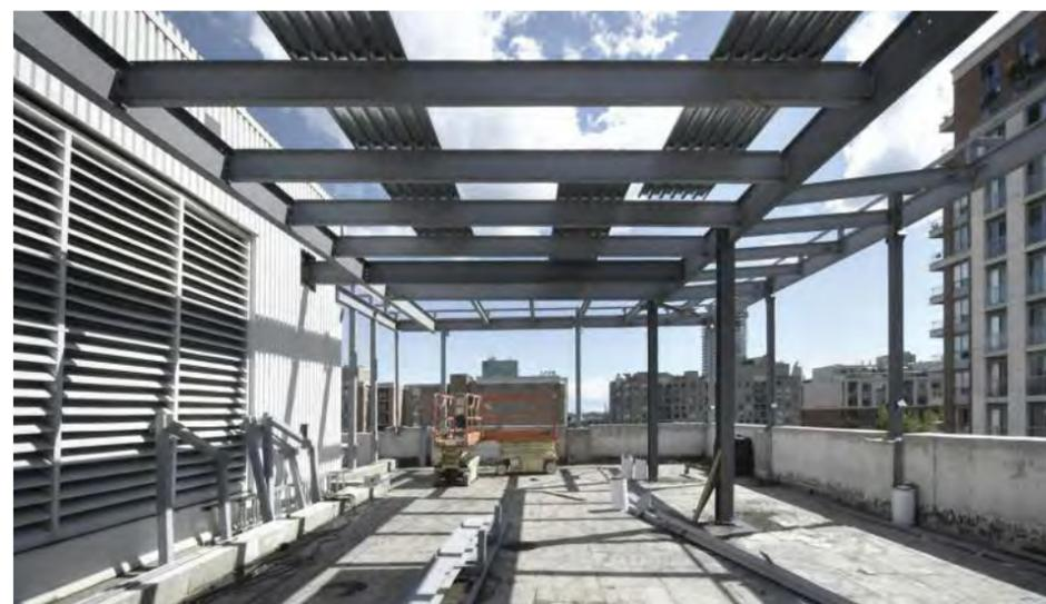
Les impératifs du calendrier de construction ont imposé l'érection de la superstructure pendant l'automne et la saison hivernale. Du fait de l'emploi d'une méthode de construction à sec, l'installation hivernale représentait une solution sûre. La préfabrication des composants a permis de poursuivre en toute sécurité les travaux de construction, tandis que le bâtiment actuel était utilisé par le personnel et les étudiants.
