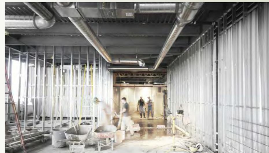
Une charpente en acier léger a été choisie en raison de ses propriétés de construction non combustibles, de son poids léger et de sa capacité d'intégration à la nouvelle structure. L'acier permet de personnaliser facilement l'ensemble de la charpente et des éléments afin de s'harmoniser avec les écarts d'espacement de la structure historique.
