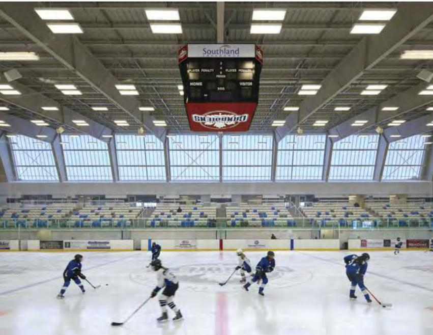
Les trois toits en acier de longue portée de l'aréna sont configurés en forme de dents de scie pour fournir une lumière naturelle sans éblouissement aux surfaces de glace. La lumière entre par l'intermédiaire de fenêtres verticales orientées vers le nord dotées de panneaux vitrés en polycarbonate à lanterneau.
