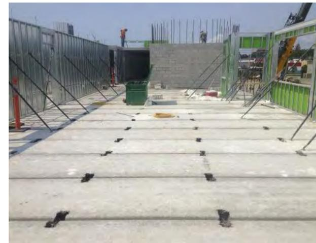
Les sections usinées à froid sont en acier galvanisé Z180 (G60) conforme à l'ASTM A653/A653M.
