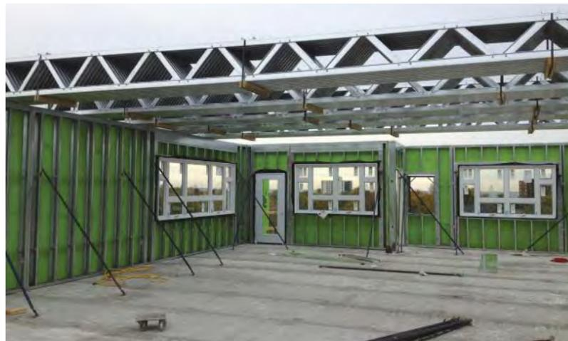
Les solives de plancher fabriquées par Magest et utilisées à Seacliff Heights utilisent de l'acier galvanisé Z275 (G90) de 1,52 mm (0,090 po), ont une profondeur de 508 mm (20 po) avec des portées variées allant jusqu'à 8,53 m (28 pi).
