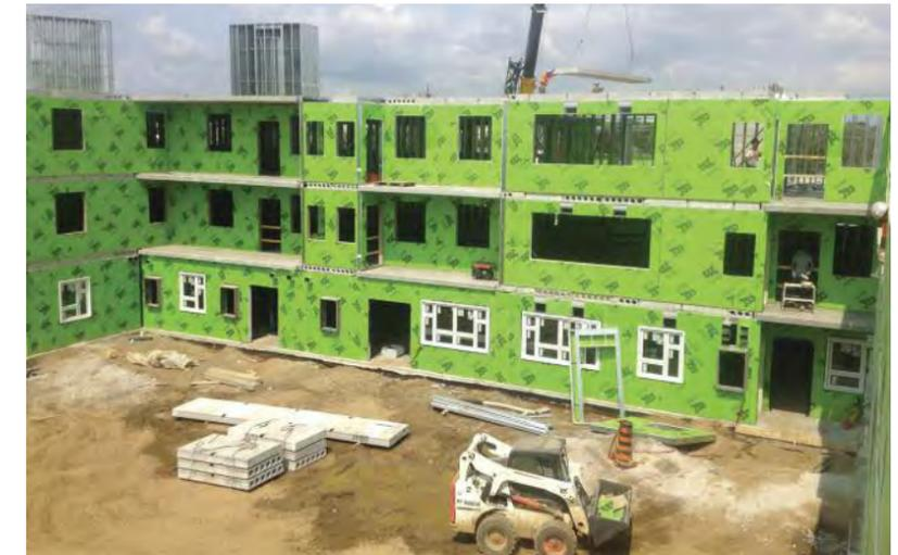
Le revêtement mural extérieur de ce projet est le revêtement CGC Securock<sup>MD</sup> Type X Sub présenté en vert. Le revêtement CGC Securock<sup>MD</sup> Brand Glass-Mat est un panneau non combustible, résistant à l'humidité et à la moisissure, conçu pour être utilisé sous des revêtements extérieurs. Le revêtement de mur fini est une combinaison de maçonnerie et d'enduit mince (EIFS).
