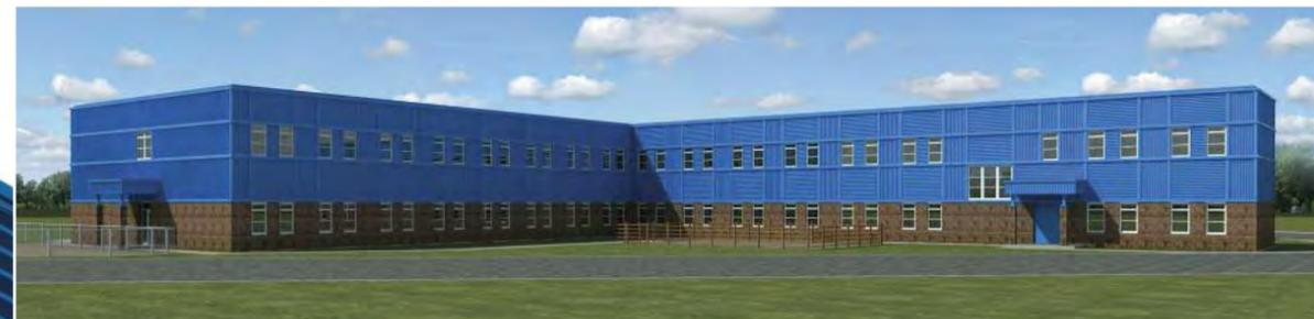
Le revêtement mural Galvalume<sup>MC</sup> AZM150 prépeint est orienté tantôt verticalement, tantôt horizontalement, pour un effet agréable qui divise visuellement la superficie de la structure à deux étages.
