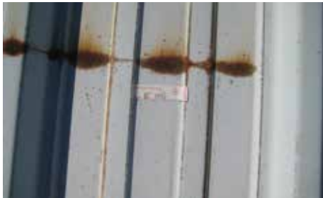
Rayure sur un toit en acier Galvanisé prépeint avec système peinture polyester après 28 années d'exposition en milieu industriel.
