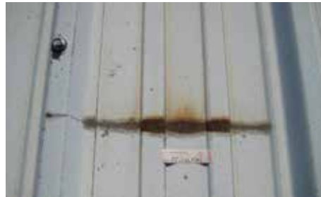
Rayure sur un toit en acier Galfan prépeint avec système peinture polyester après 28 années d'exposition en milieu industriel.
