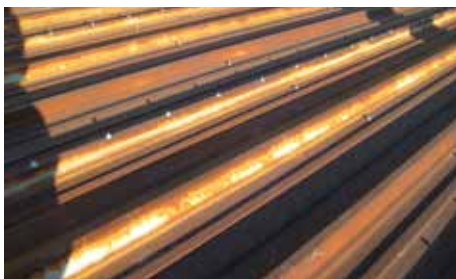
Toiture en acier Galvanisé nu après 28 années d'exposition.
