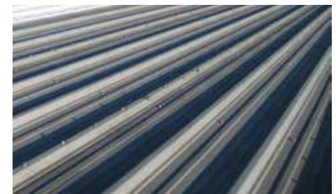
Toiture en acier Galvalume après 28 années d'exposition.
