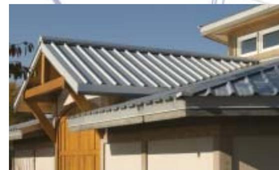
**Galvalume Plus AZM180 non peint de Dofasco a servi pour les panneaux de profil 7-150F de Agway Metals. Le temps et la recherche ont démontré que les toitures métalliques Galvalume durent plus longtemps sans nécessiter beaucoup d'entretien et donnent une valeur exceptionnelle.**
