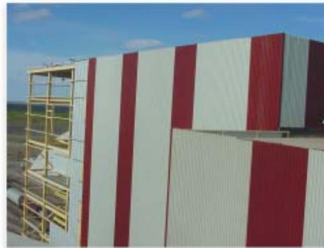
135 000 pi<sup>2</sup> de 8/8 mils de Barriercoat avec le revêtement mural extérieur de profil S-15-SB coloré Blanc os QC1508, Blanc intérieur QC1546 et Rouge tuile QC1558 ont été posés. 32 000 pi<sup>2</sup> de platelage en tôle, fabriqué à partir de 8/8 mil Barriercoat coloré Blanc intérieur QC1546 des deux côtés, a servi sous la multicouche et 5 000 pi<sup>2</sup> était destiné au platelage.
