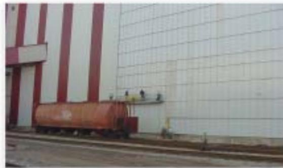
L-32 et Valu-Clad fournis par le Groupe de laminage ont 0,76 mm (0,030 po) 8/8 (mils) et sont peints des deux côtés Blanc intérieur QC1546. L-32 a servi de panneau-sandwich mural extérieur et Valu-Clad a permis d'insérer la gaine d'ascenseur dans le bâtiment et à l'intérieur du mur extérieur pour empêcher la poussière d'entrer dans les liernes et en prolonger la durée.
