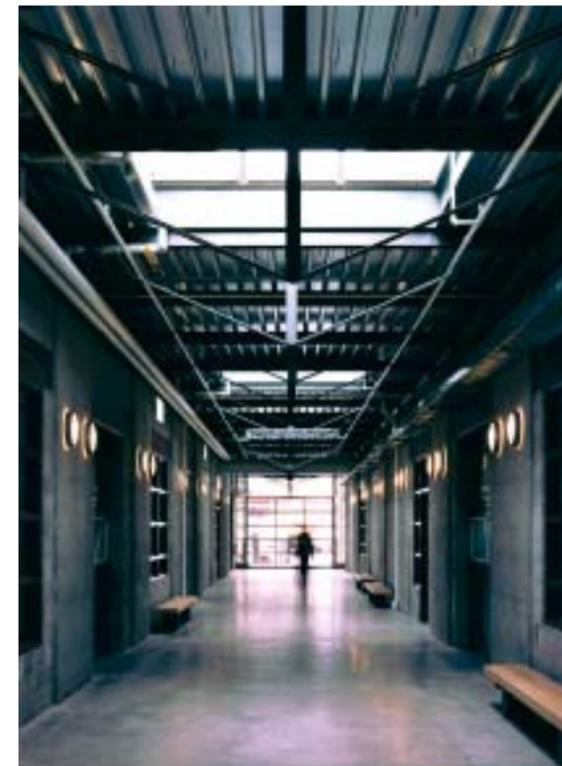
flexibilité et qui augmentent l'impression d'espace. Les murs de remplissage et mitoyens sont faits de blocs en béton, alors que les salles de classe possèdent une charpente métallique. Les deux sont plaqués d'un revêtement extérieur galvanisé ondulé Z275 à « écran pare-pluie » prépeint Gris régé QC 8730 d'une épaisseur de 7/8 po. De la brique est également utilisée aux niveaux inférieurs.
