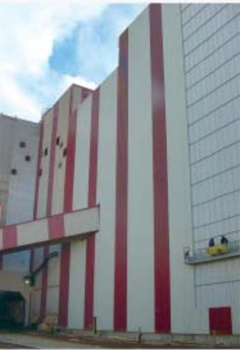
L'expansion des installations commence là où le transporteur sort du bâtiment. La première des deux séries de bandes est le plus ancien revêtement revêtu d'une mince couche. Le revêtement épais Barriercoat est installé en premier plan. Le revêtement gris dans le fond est de la tôle d'aluminium décolorée encore en mauvais état et qui pourrait être remplacée par du Barriercoat dans un avenir prochain pour correspondre au revêtement de l'expansion.
