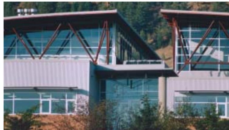
▲ Niveau du vide sous comble vitré au-dessus des salles de classe montrant les poutres tridimensionnelles et le toit galvanisé Z275 prépeint Gris régent QC8730.
