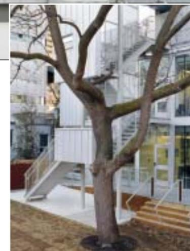
**CI-DESSUS :** Rencontre de tous les matériaux sur la façade nord : acier Galvalume, cèdre, brique foncée, verre et rampes à treillis perforé. L'acier Galvalume Plus AZM180 de Dofasco a été fourni par Agway Metals pour le parement de leur profilé à joint debout AZ-38.
