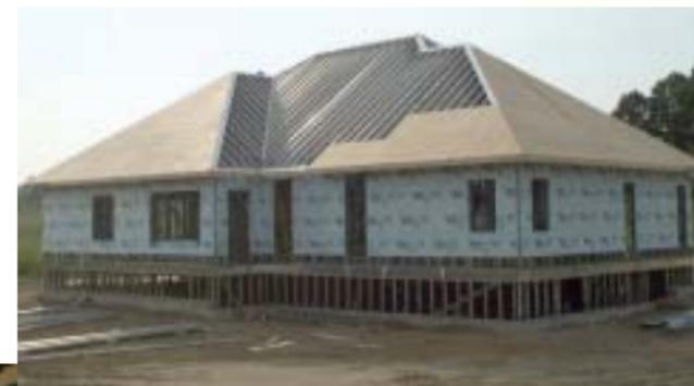
**La charpente en acier léger est une technologie éprouvée et traduit la force et la constance supérieures de l'acier. Étant inorganique, l'acier ne contribue pas à la croissance de moisissures et ne libère pas de gaz. Il participe donc à une excellente qualité de l'air intérieur.**
