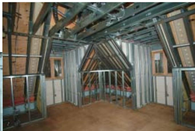
**Des éléments de charpente en acier de diverses tailles et formes standard, et d'épaisseurs variées, ont été utilisés pour répondre à pratiquement tous les besoins structuraux.**
