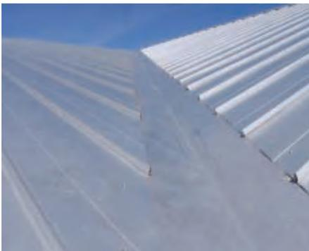
Le toit est revêtu d'acier AZ180 Galvalume Plus non peint d'une épaisseur de 0,76 mm (0,0299 po) à profil Tradition. Le toit des deux garages, d'une superficie au sol de 241 m<sup>2</sup> (2 594 pi<sup>2</sup>), et l'autre de 215 m<sup>2</sup> (2 314 pi<sup>2</sup>), sont munis de revêtements similaires. Un total de 1 486 m<sup>2</sup> (16 000 pi<sup>2</sup>) de revêtement couvre les trois toits.
