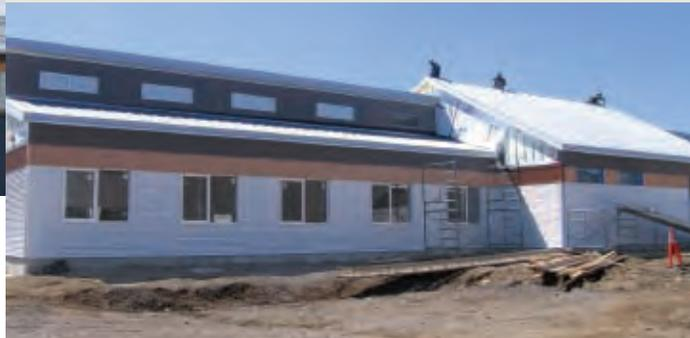
L'acier Galvalume Plus<sup>mc</sup> répondait aux critères liés à la teneur en matériaux recyclés de la certification LEED avec 15 % de matières recyclées après consommation et 22 % de matières recyclées avant consommation. De plus, il s'agit d'un matériau recyclable. L'utilisation de revêtements muraux en acier Galvalume plutôt qu'en vinyle a permis au bâtiment d'être admissible à un crédit de bâtiment durable LEED.
