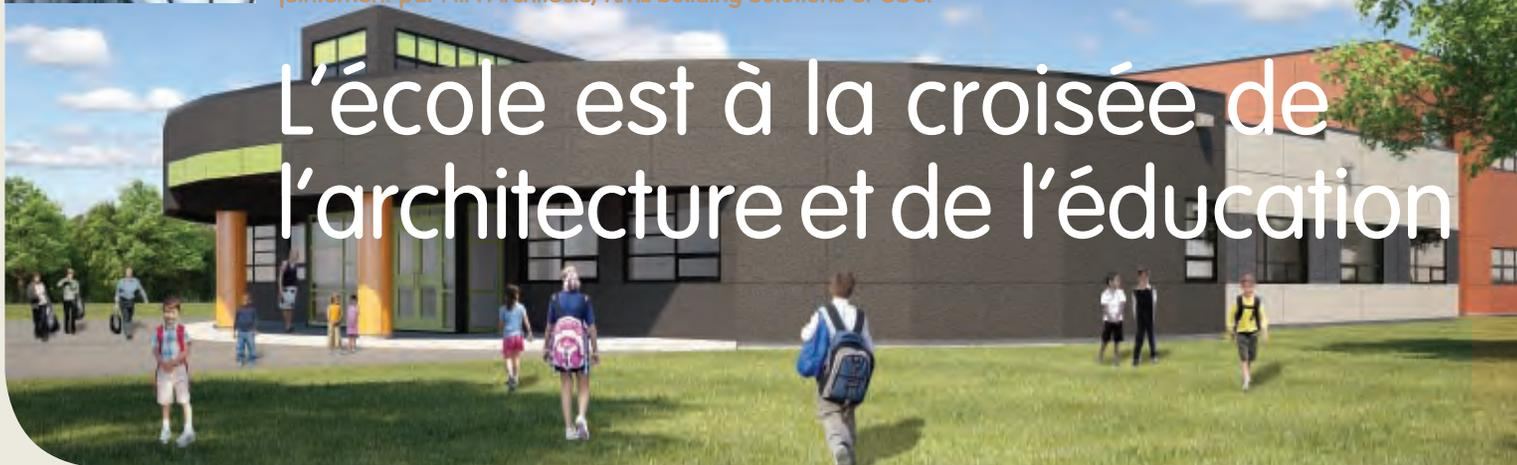
Les murs extérieurs et intérieurs, ainsi que la structure du toit, ont été fabriqués à l'aide d'acier de faible épaisseur. Construit à l'aide d'acier à teneur très élevée en matériaux recyclés, le système a été conçu pour les bâtiments nécessitant un indice d'isolation plus élevé et présentant des échéances de construction serrées comparativement aux pratiques de construction des écoles traditionnelles.
