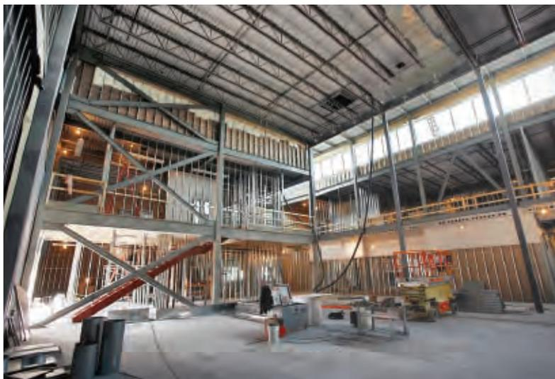
Résistante, précise, stable et durable, la charpente métallique légère permet d'éviter les problèmes tels que les fissures et les déformations des solives et des poutres. L'acier se compose en majeure partie de produits de post consommation recyclés et il s'agit d'un matériau écologique.
