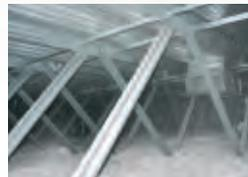
poutres. Les murs et la section au dessus du plafond structurel sont bien ventilés pour que l'isolation reste sèche et efficace.
