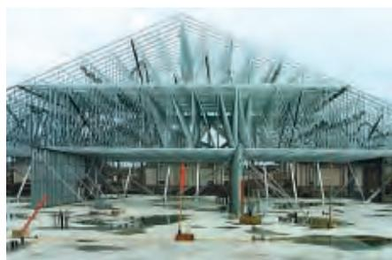
La technologie des charpentes métalliques légères est éprouvée et reflète le niveau supérieur de résistance et d'uniformité de l'acier. Étant un produit artificiel, l'acier ne favorise pas la croissance de moisissure et ne crée aucun gaz, contribuant ainsi à la qualité de l'air intérieur.
