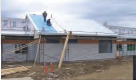
1 579 m<sup>2</sup> (17 000 pi<sup>2</sup>) de revêtement d'acier AZM150 Galvalume prépeint de 0,61 mm (0,0239 po) à profil ondulé de 22 mm (0,875 po) ont été utilisés pour les revêtements de l'immeuble à bureaux et des garages.
