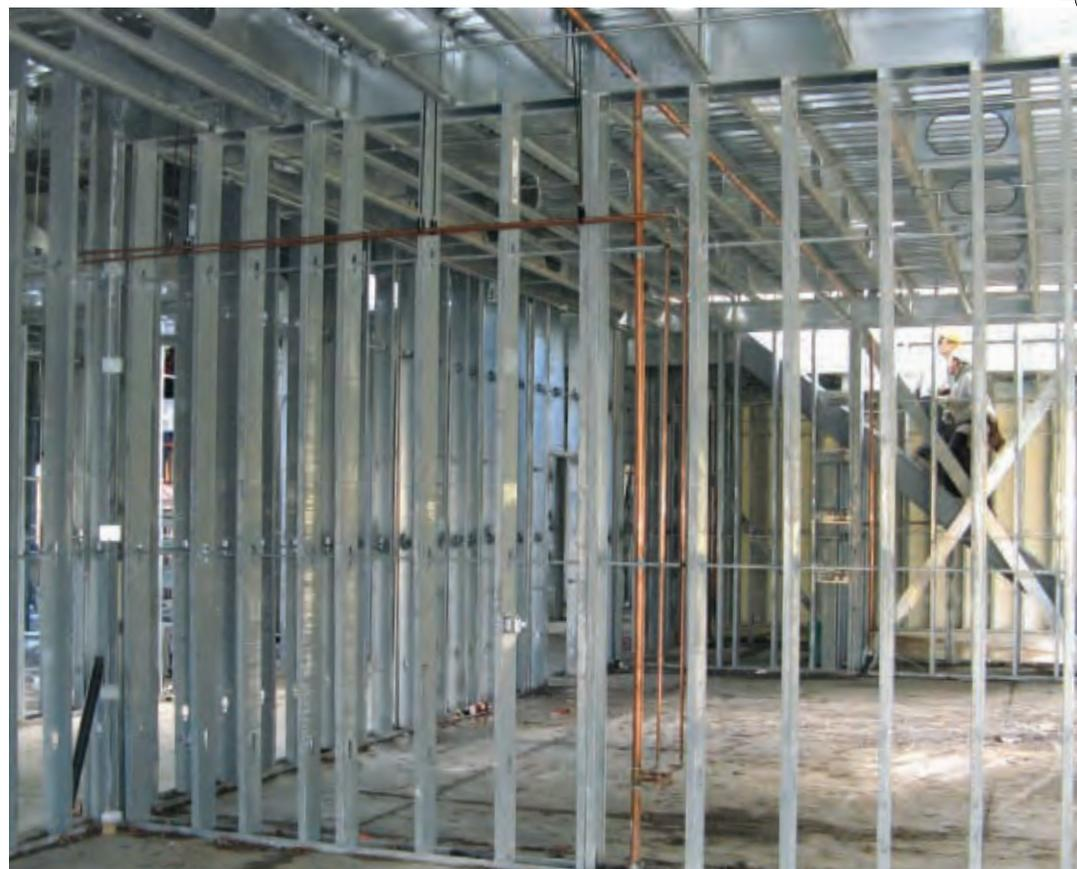
Système de cloisons intérieures polyvalent, la disposition des salles de classe peut suivre l'évolution des technologies.
