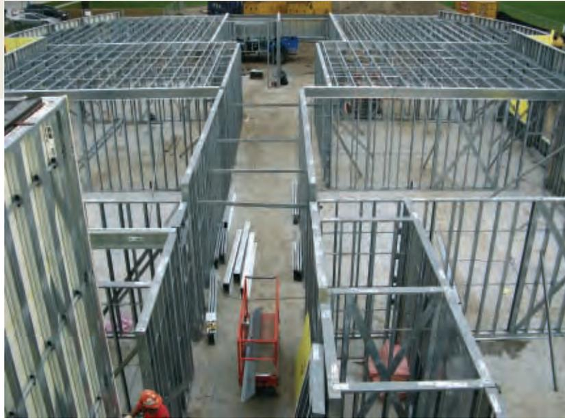
Les assemblages à charpente métallique légère de l'école résistent à la moisissure, sont inertes et ne libèrent aucun gaz.
