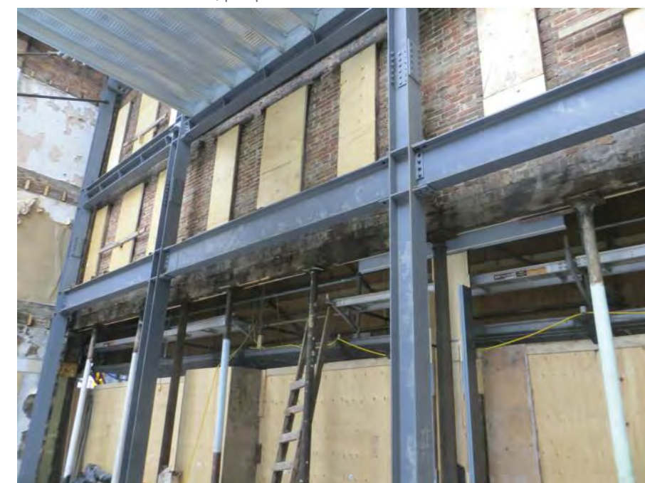
ComSlab au rez-de-chaussée, prêt pour couler le béton.
