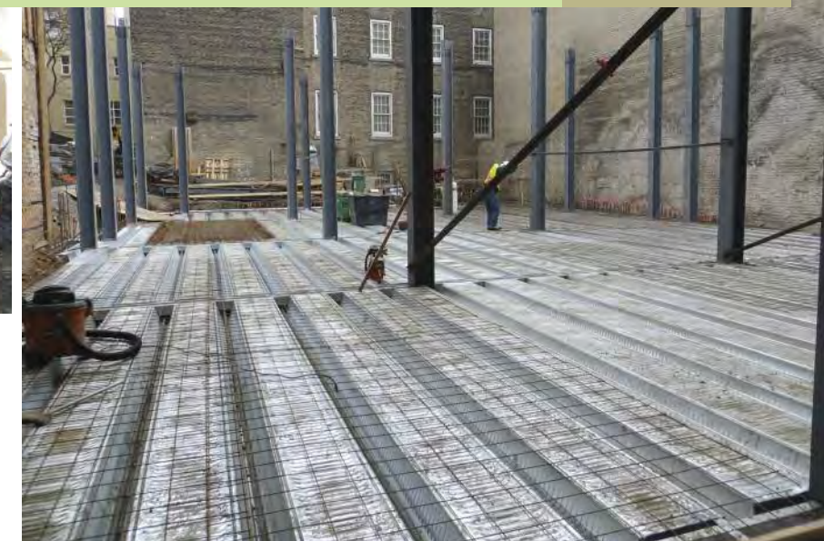
ComSlab au rez-de-chaussée, prêt pour couler le béton.
