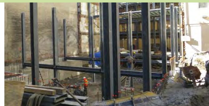
Construction d'une nouvelle structure en acier et en ComSlab.
